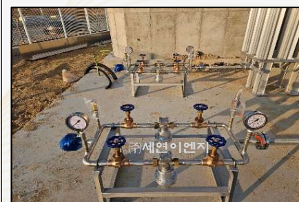
N2 GAS RACK 설치
