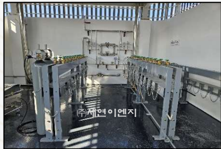
MIX GAS RACK 설치
