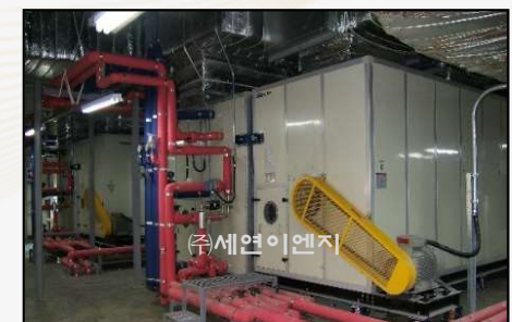
제습 공조기 설치
