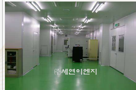
CLEAN ROOM 내부(무정전 에폭시)
