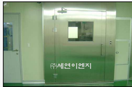
PASS ROOM 설치
