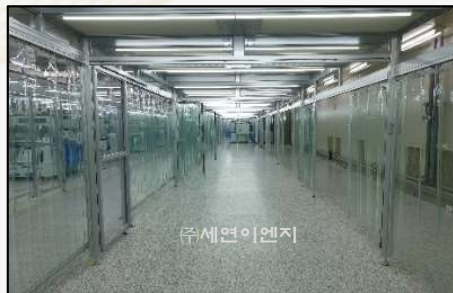
T/D LIGHTING 설치
