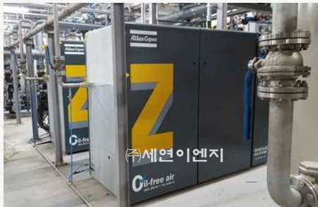
CDA COMPRESSOR 설치
