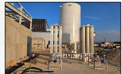
N2 GAS RACK 설치
