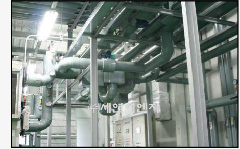
UTILITY 배관 설치
