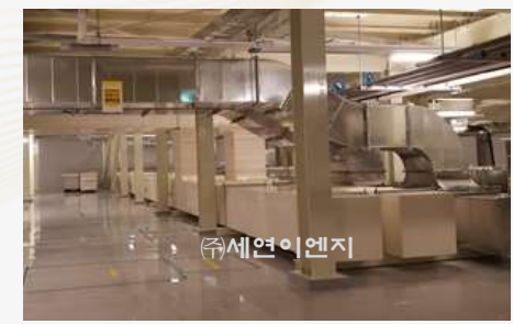
C/R 하부 FAB DUCT 공사
