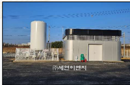
MIX GAS RACK 설치
