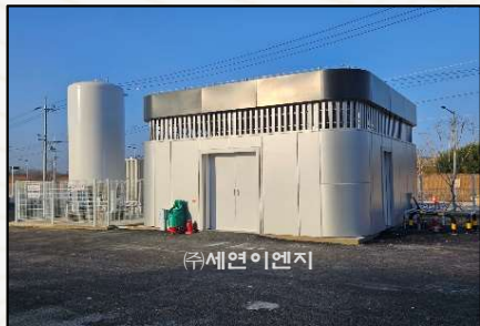
H2 GAS RACK 설치
