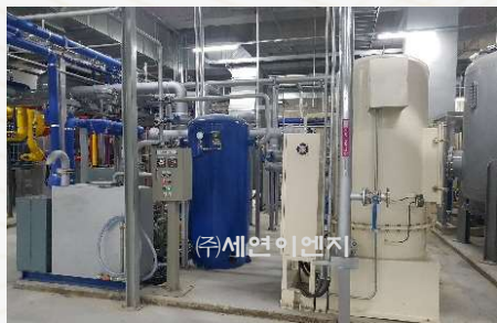
Clean & Process Vacuum 장비 설치
