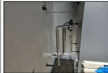
MIX GAS (N2+H2) 설치
