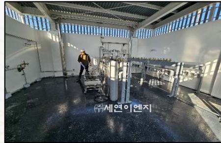
MIX GAS RACK 설치
