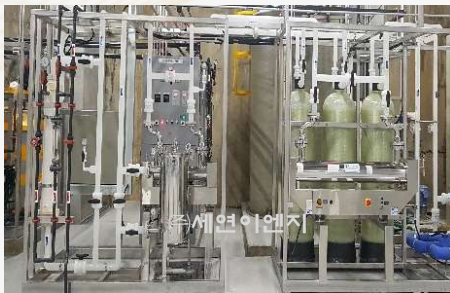
DI Water System 설치
