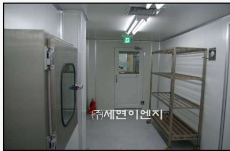
건축 내장 공사
