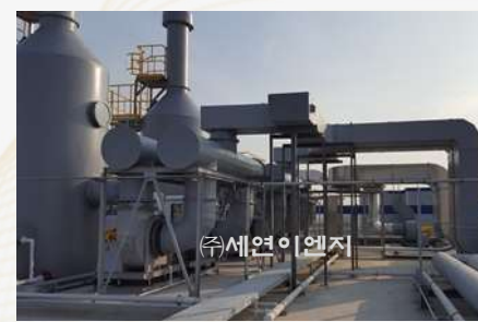
AL & ACID 옥외 DUCT 공사
