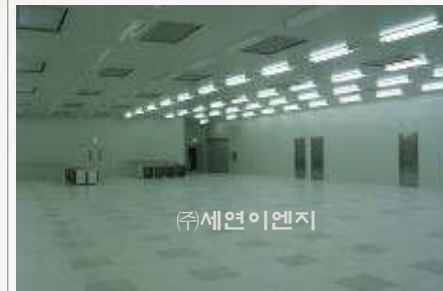
CLEAN ROOM 내부(전도성 타일)
