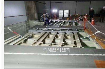
제진대 스트럭처 설치
