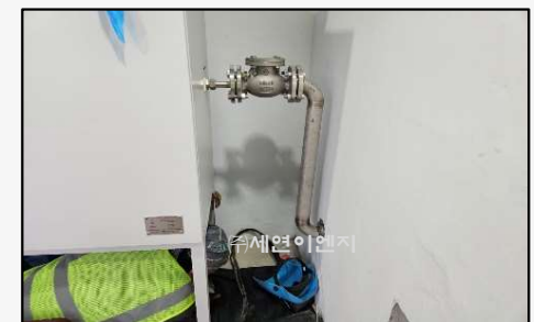
MIX GAS (N2+H2) 설치
