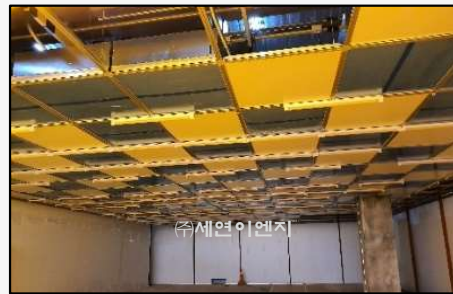
FFU 및 ULPA FILTER 설치
