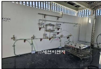
H2 GAS RACK 설치
