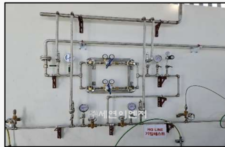
H2 GAS RACK 설치
