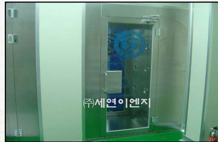
AIR SHOWER 등 무진기기 설치
