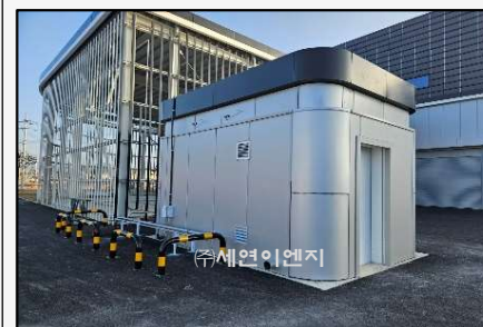
MIX GAS (N2+H2) 설치
