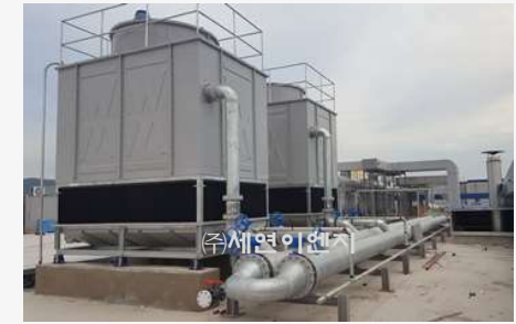
Cooling Water Piping 공사
