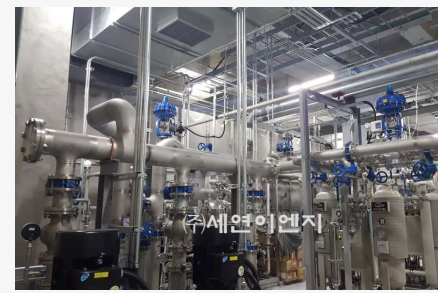
PCW Piping 공사
