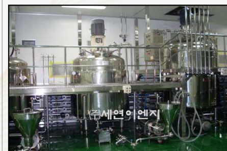
정제수 설비 설치
