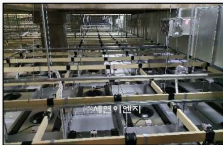
SYSTEM CEILING FFU 설치
