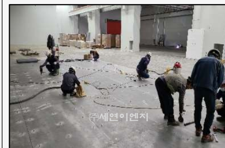
바닥 SUS판 용접설치
