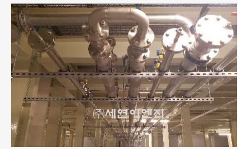
N2 & CDA Piping 공사
