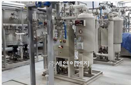
AIR DRYER 설치
