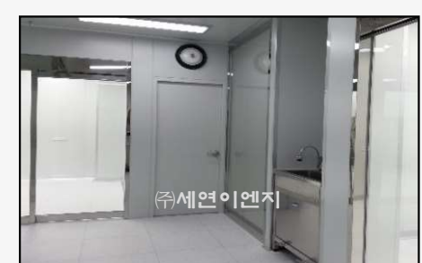
수술실 시설 공사
