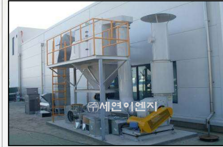
집진 설비 설치
