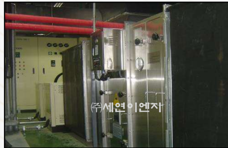
탈취 설비 공사
