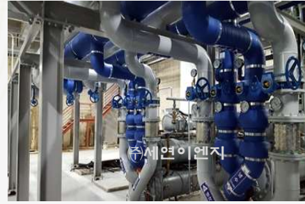
Chilled Water Piping 공사
