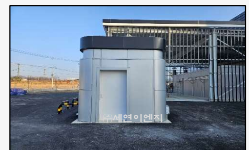
MIX GAS (N2+H2) 설치
